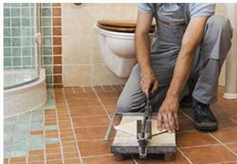
Foto: IG BAU
