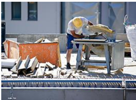
Foto: IG BAU
