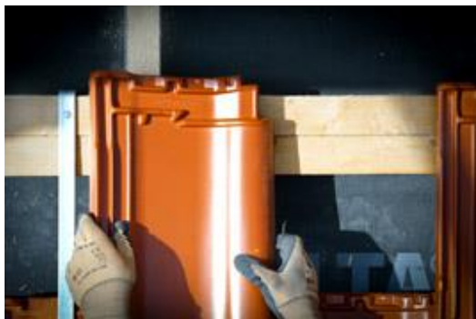
Foto: IG BAU
